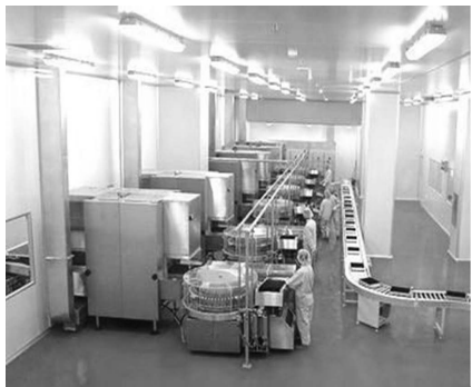
图 2 制药厂空调密封间
